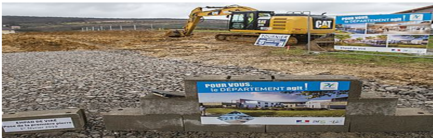
Pose de la première pierre de l'EHPAD de Viré
