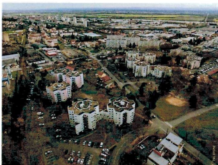
La Chanaye-Résidence – AL Drone - Mâcon Habitat mars 2023
